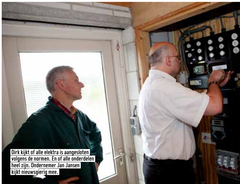
Dirk Klompmaker van elektrotechnisch bureau Synorga voert de keuring uit. Hij pakt de apparatuur die hij nodig heeft uit zijn auto.
